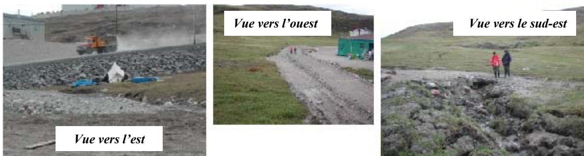
Figure 69: Remblai de route et radier près du site microclimatique #12.
